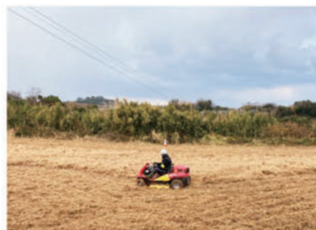
太陽光パネル設置に向けて場内整備(除草)の様子
