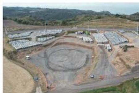
太田江地区の資材置き場に搬入された杭、架台等の材料
