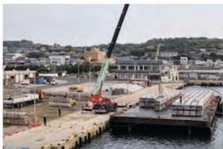
平港での杭、架台等の搬入状況
