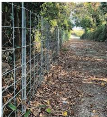
除草・補修後のイノシシ柵(神浦地区)
