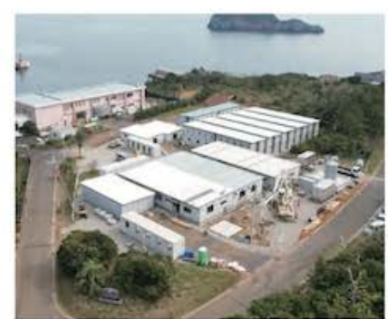
作業員宿舎建設の状況
