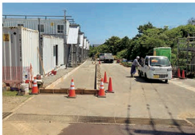
シーパークホテル跡地作業員宿舎建築工事(増設)の様子
