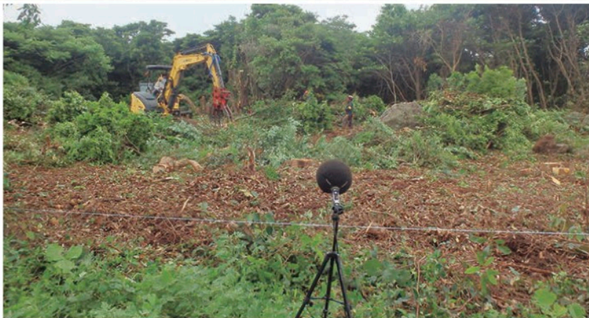
3工区飯良地区 伐採工事時の騒音測定の様子
