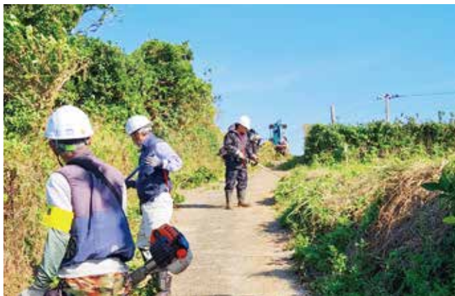
道路沿いの除草作業の様子
