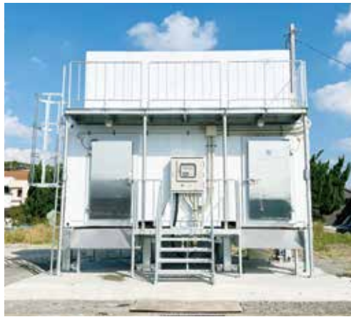
設置が完了した製氷機と貯氷庫
